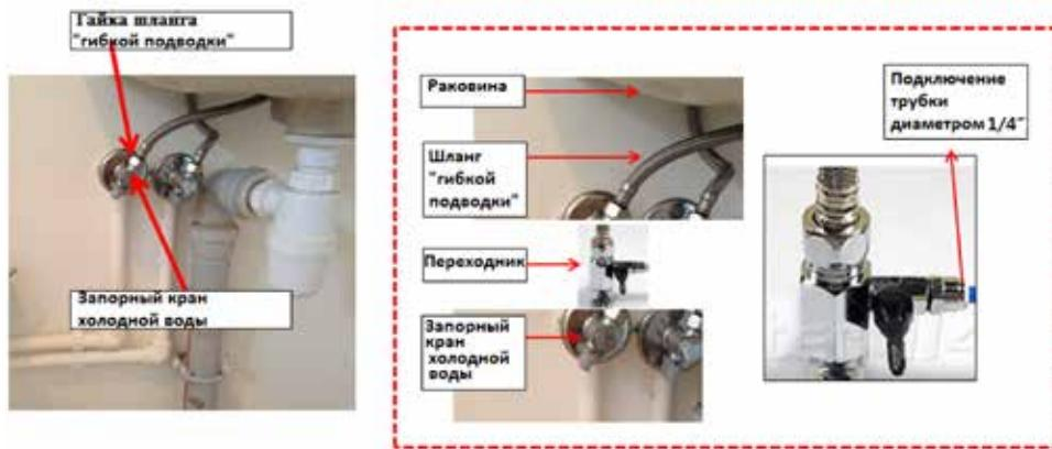
**2.** Подключите полипропиленовый трубопровод (1/4 дюйма) к переходнику (не допускайте использования слишком коротких или сильно изогнутых шлангов). Соедините второй конец полипропиленового трубопровода с входным штуцером 1, расположенным на задней стороне диспенсера.
